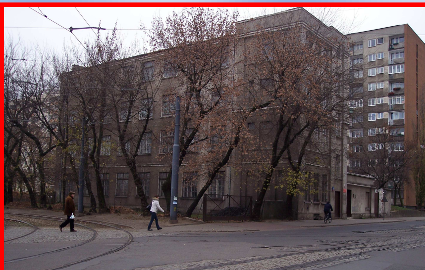
Ul. Kawęczyńska - istniejąca nawierzchnia jest zniszczona, brak wydzielonych przejść dla pieszych
